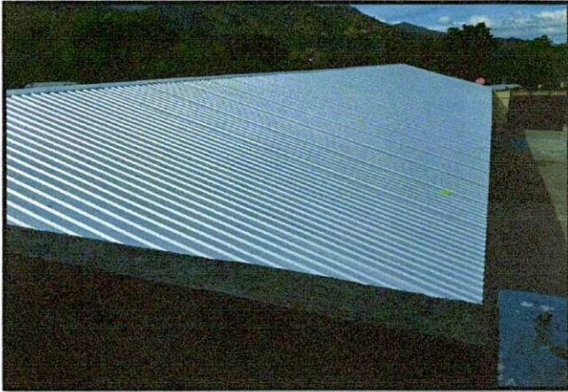
Foto 1: INSTALACION DE LÁMINA TROQUELADA EN AULAS Y DIRECCION. (MODULO I)
