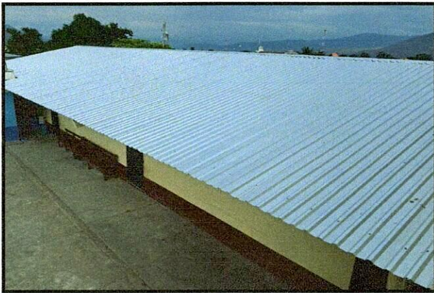
Foto 3: INSTALACION DE LÁMINA TROQUELADA EN AULAS. (MODULO II)
